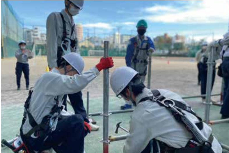
支柱の取付け
