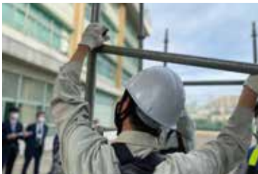
布材の取付け
