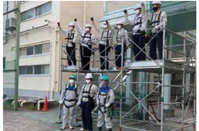
足場が完成して全員でガッポーズ!
